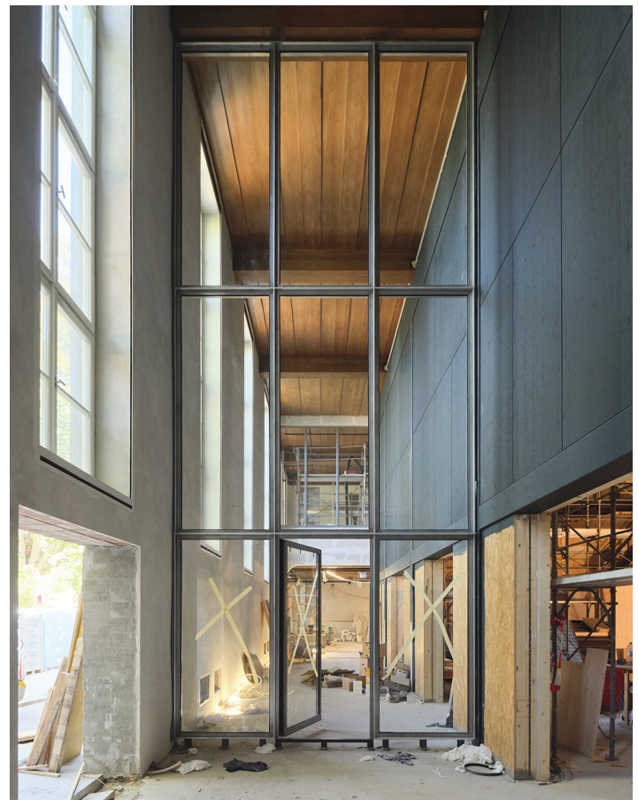
Laufende Bauarbeiten am Theatersaal, Fotografie © Basile Bornand
